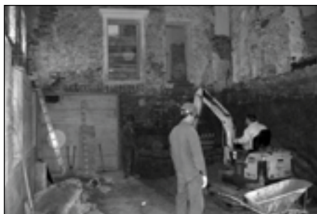
izkop kleti za bodočo kotlovnico ...
