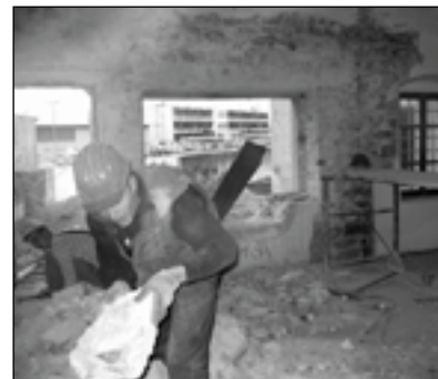
Na gradbišču je skrb za varnost zelo pomembna, saj je delo težko, prašno, izčrpajoče, nevarnost pa preži na vsakem koraku.
