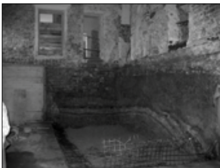
... in podbetoniranje temeljev v nekdanji kapeli sv. Andreja.
