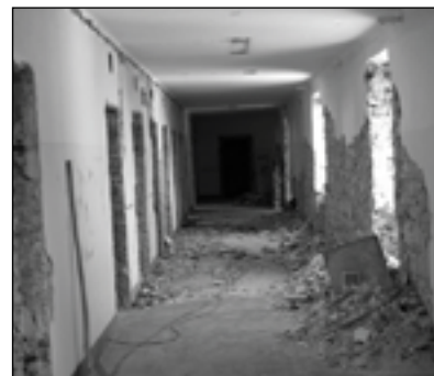
Glejte, tu so odstranili staro, neuporabno stavbno pohištvo. Kasneje so morali še tlak zaradi statične preobremenitve.
