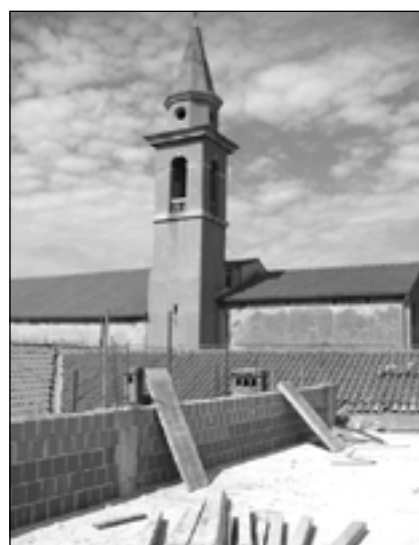
Pogled na zvonik cerkve s »podstrešja« nadomestne gradnje.
