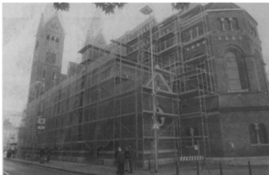
Vsa obnovitvena dela na zunanosti bazilike frančiškanske cerkve bodo v tem tednu končana, zatem pa bodo gradbene odre podirili. (Janiko Rath)
