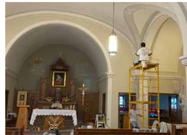
Nujno beljenje cerkvenega stropa
